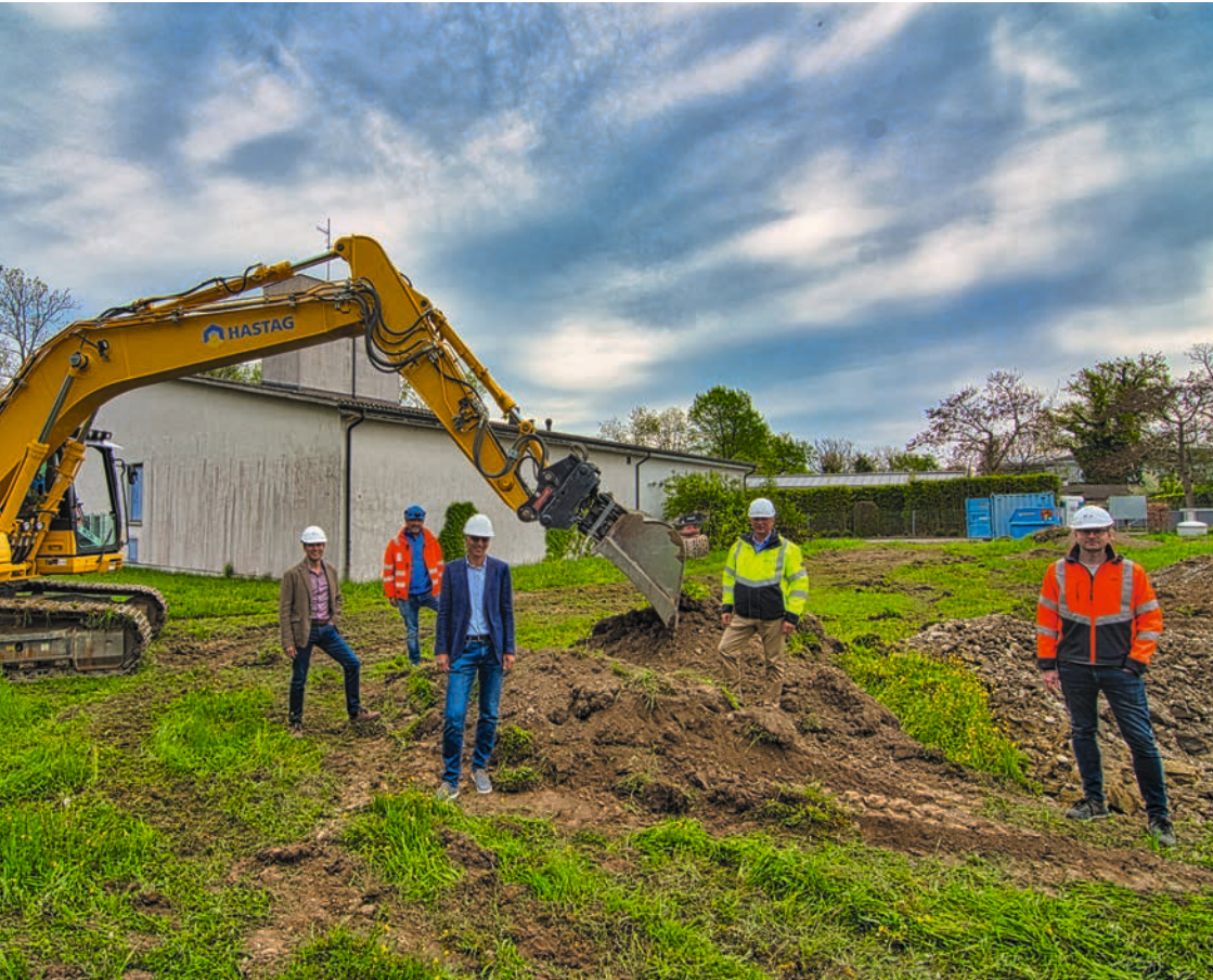
Oben: Spatenstich vom 21.04.2020 Erweiterungsbau Seewasserwerk Kesswil.
