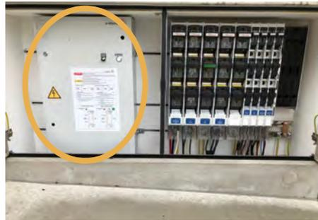
*Steuerunit zu Regeltransformator, der sich im Kabelschacht befindet.*
