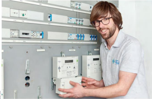
Christoph Eigenmann, Elektroinstallateur und Fachspezialist.
