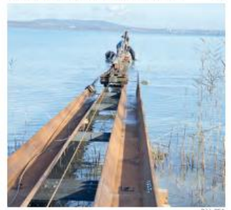
Auf dieser Schiene werden die Rohre nach und nach ins Wasser gelassen.
