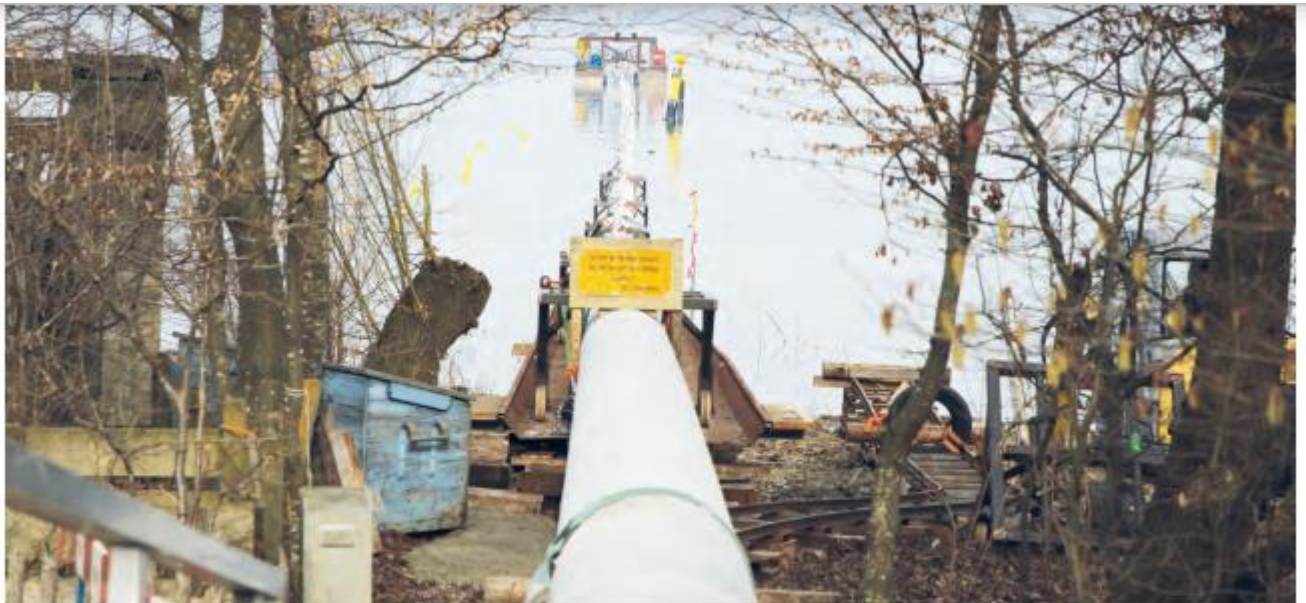
Zwei 512 Meter lange Rohre werden in Güttingen zusammenschweisst und schliesslich mit fünf Booten nach Kesswil geschleppt.
